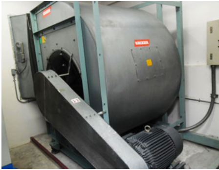
พัดลมอัดอากาศ (Stair Pressurized Fan)
