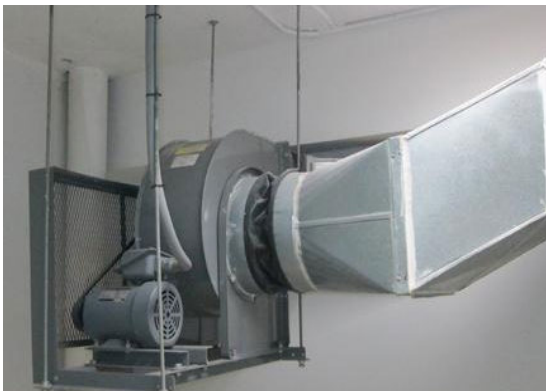
พัดลมดูดอากาศ (Exhaust Fan)
