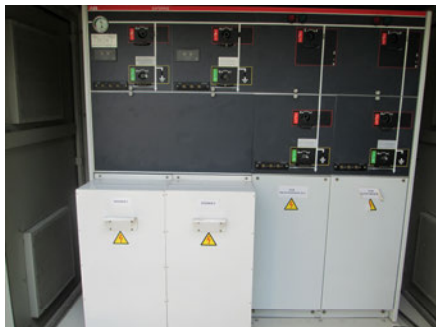
ตู้สวิตช์ตัดตอนและจ่ายกระแสไฟฟ้าแรงสูงใต้ดิน (Ring Main Unit)
