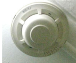
เครื่องตรวจจับความร้อน (Heat Detector)
