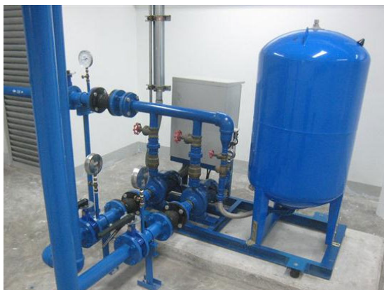
เครื่องสูบน้ำเพิ่มแรงดัน (Booster Pump)
