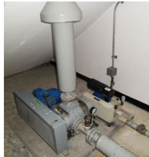
เครื่องเติมอากาศ (Aerator Pump)
