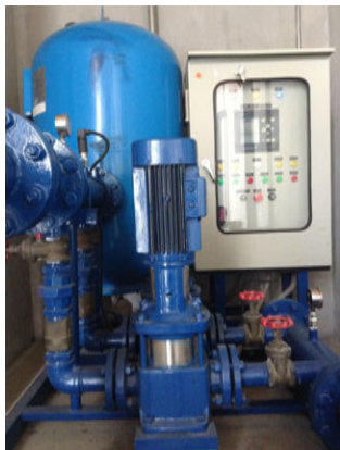
เครื่องสูบน้ำเพิ่มแรงดัน (Booster Pump)
