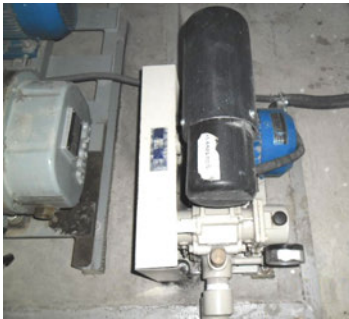
เครื่องเติมอากาศ (Aerator Pump)
