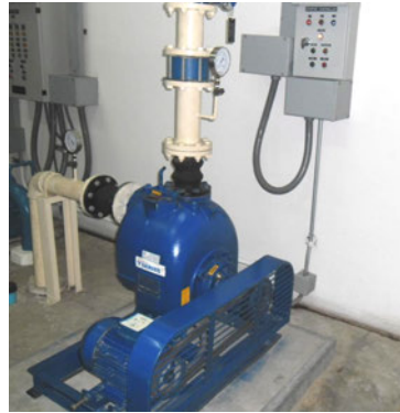
เครื่องสูบน้ำทิ้ง / นำเสีย (Drainage / Sewage Pump) /
