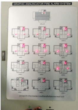
ตู้แผนผังแสดงผล ตำแหน่งเกิดเหตุเพลิงไหม้ (graphic annunciator)
