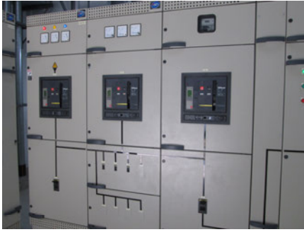
แผงควบคุมไฟฟ้าหลัก (Main Distribution Unit - MDB)
