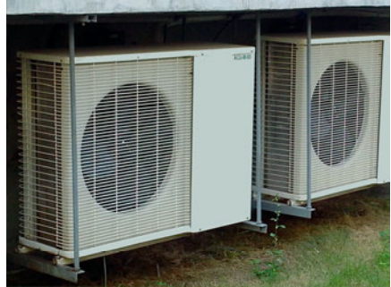
เครื่องระบายความร้อน (Condensing Unit)
