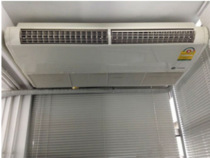
เครื่องส่งลมเย็นขนาดเล็ก (Fan Coil Unit)
