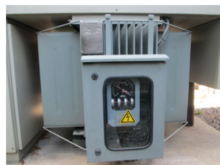
หม้อแปลงไฟฟ้า (Transformer)
