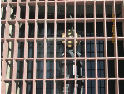
เครื่องสูบน้ำทิ้ง / นำเสีย (Drainage / Sewage Pump) /
