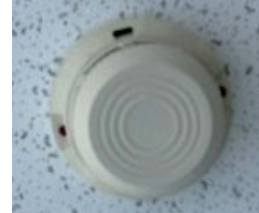
เครื่องตรวจจับควันไฟ (Smoke Detector)
