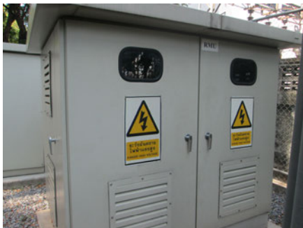
ตู้สวิตช์ตัดตอนและจ่ายกระแสไฟฟ้าแรงสูงใต้ดิน (Ring Main Unit)
