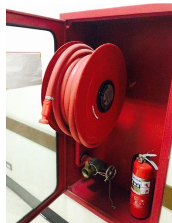
รูปที่ 9 ตู้ดับเพลิงที่มีสายส่งน้ำแบบขมวดม้วน
