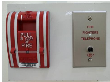
รูปที่ 43 อุปกรณ์ส่งสัญญาณเตือนไฟไหม้
