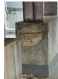
2. เสาฐานของหอทำความเย็น Cooling Tower จำนวน 5 ชุด
