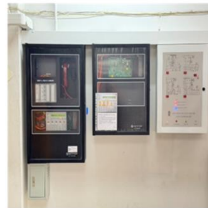
ติดตั้งระบบ fire alarm และ กันซึมดาดฟ้า อาคาร 50 ปี
