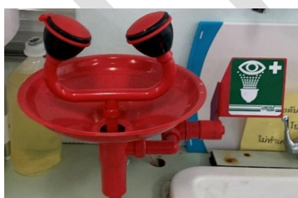
อุปกรณ์ล้างตาฉุกเฉิน
